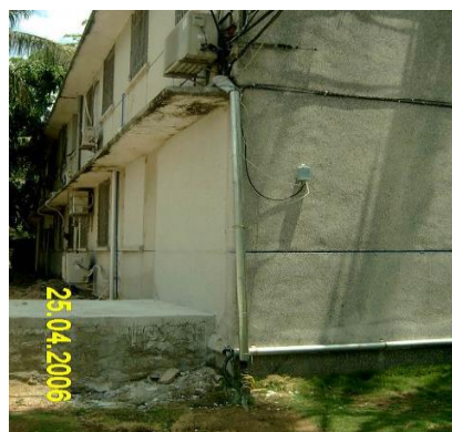
附图二 对干扰电缆的处理（屏蔽）
